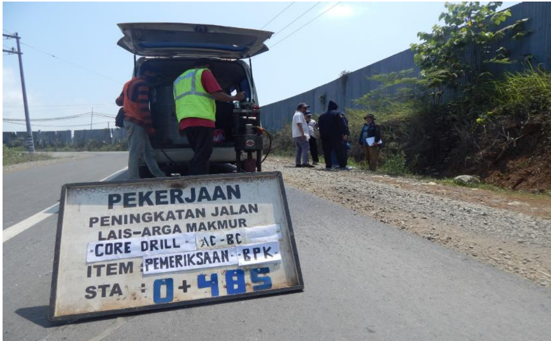
Gambar 7. Pemeriksaan BPK atas Belanja Modal dan Infrastruktur Tahun Anggaran 2019
